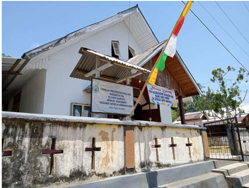
Gambar 1.1 Gedung Gereja Eben-Haezer Jemaat GPM Sokowati (Sumber: Dokumentasi TIM PkM, 08 November 2023)
